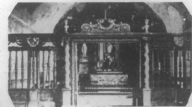
Interior de la Iglesia Subterránea de Haute-Isle.
